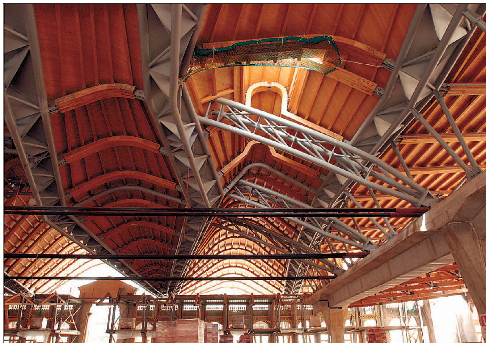
Vista panorámica del mercado de Santa Caterina, con las grandes estructuras que sustentan la cubierta de madera.
